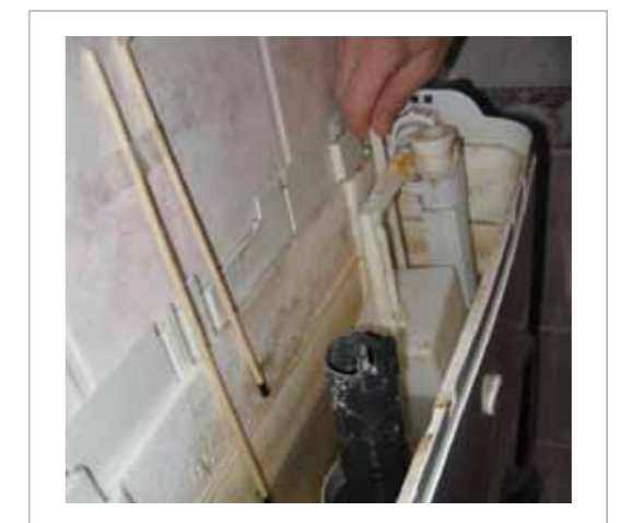
Úszószint beállítása a WC tartályban: csak néhány csavarás kérdése
